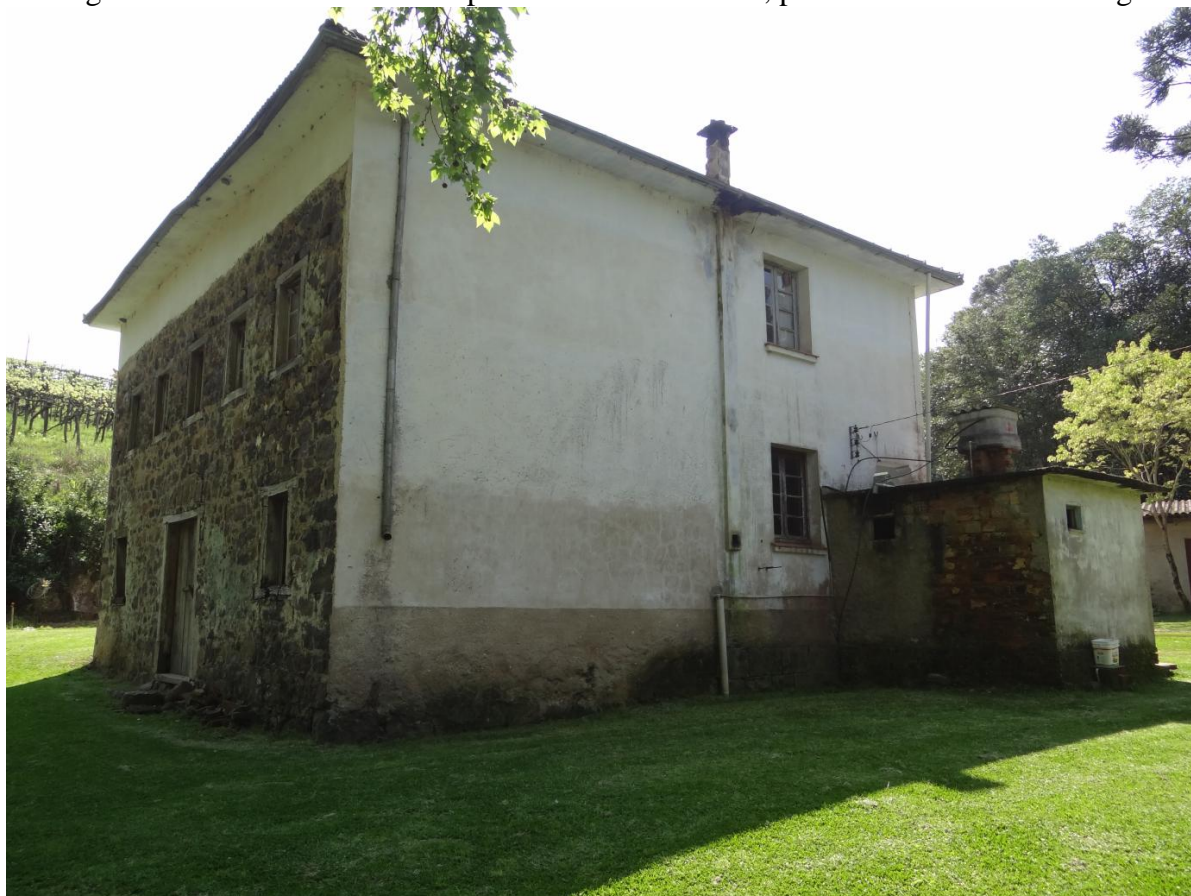
Figura 10 – Casa com o reboco parcialmente removido, pertencente à família Arsego.
