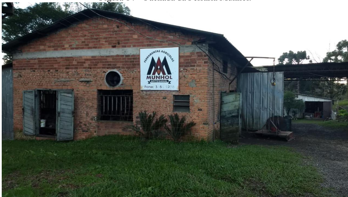
Figura 14 – Fachada da Ferraria Munhol.
