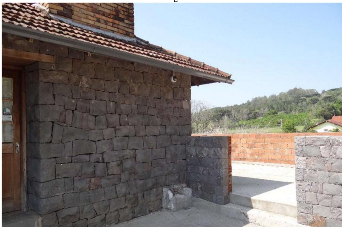
Figura 23 – Detalhes da disposição das pedras no restaurante, separando a construção nova da antiga.
